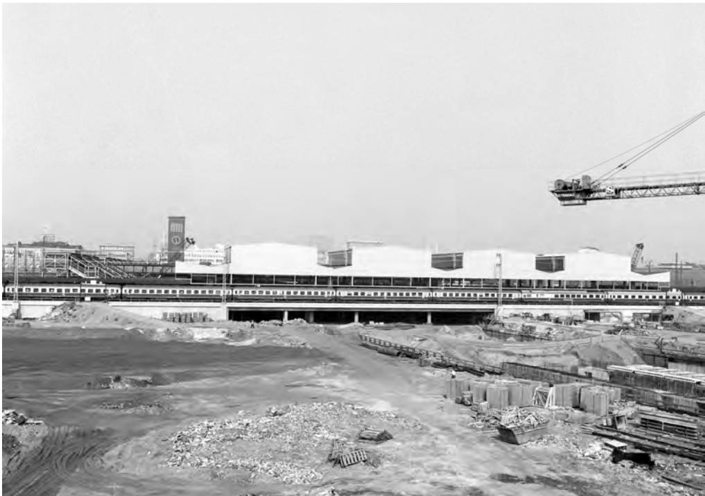
Abriss des Oberbilker Stahlwerks, ca. 1983 Quelle: ThyssenKrupp Konzernarchiv Duisburg
