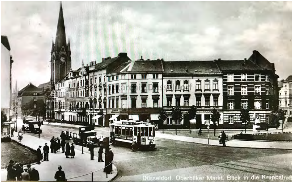
Häuserzeile am Oberbilker Markt, Blick in die Kruppstraße; Quelle: © StaD 5-8-0-034652.0015
