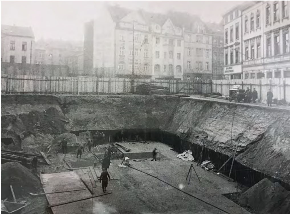
Blick in die Baugrube an der Ecke zur Kruppstraße, 28.01.1941,
