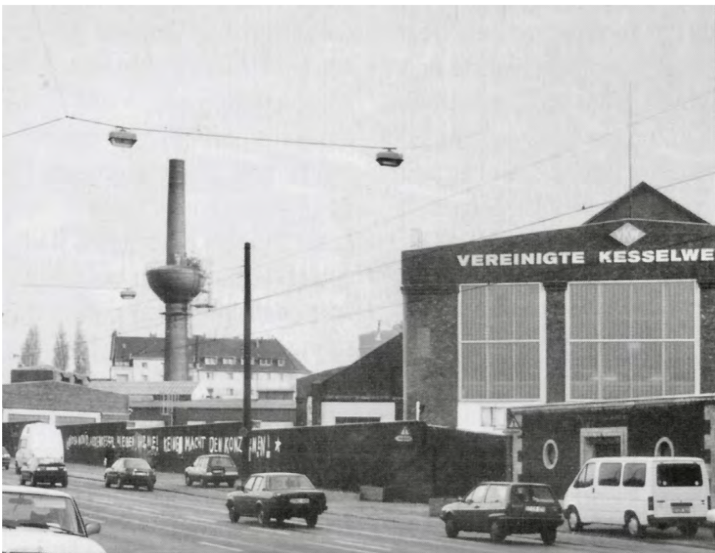
Vereinigte Kesselwerke (VKW) an der Werdender Straße (ca. 1975) Der Schornstein mit ringförmigem Wasserkessel war bis zur Werksschließung 1991 ein Wahrzeichen Oberbilks und eine sichtbare Erinnerung an die industrielle Vergangenheit des Stadtteils. Quelle: Stad
